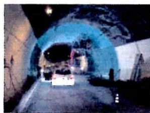
i lavori in corso sulla A18
